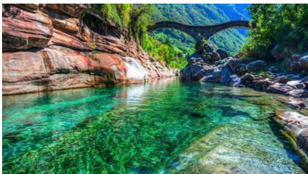
PONTE DI LAVERTEZZO, VALLE VERZASCA
